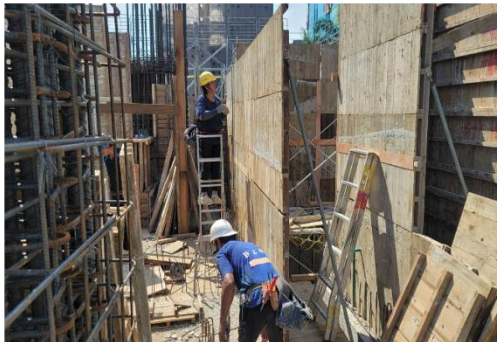
A棟1MF牆模組立 麒麟8/19
