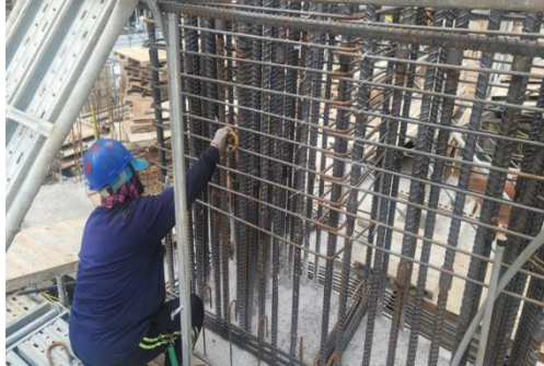
A棟1MF柱筋組立 宏峻8/16
