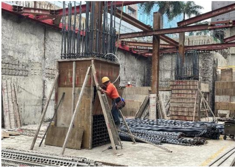
A棟 B2FL柱牆模版組立 騏駿5/8
