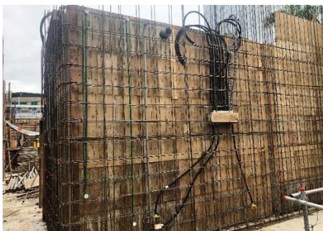
C棟B1牆機電配管 明鴻 6/20
