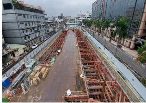
全區俯視施工構台 根基 1/29
