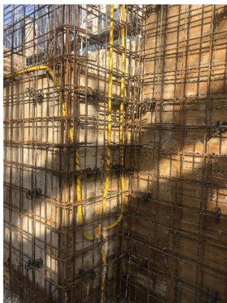
D棟 3FL牆筋綁紮完成 宏峻1/25
