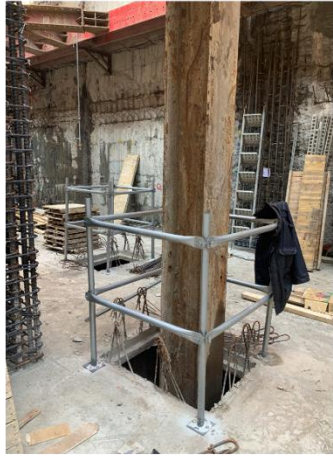
ABC區B5中間樁護欄 太穩1/29
